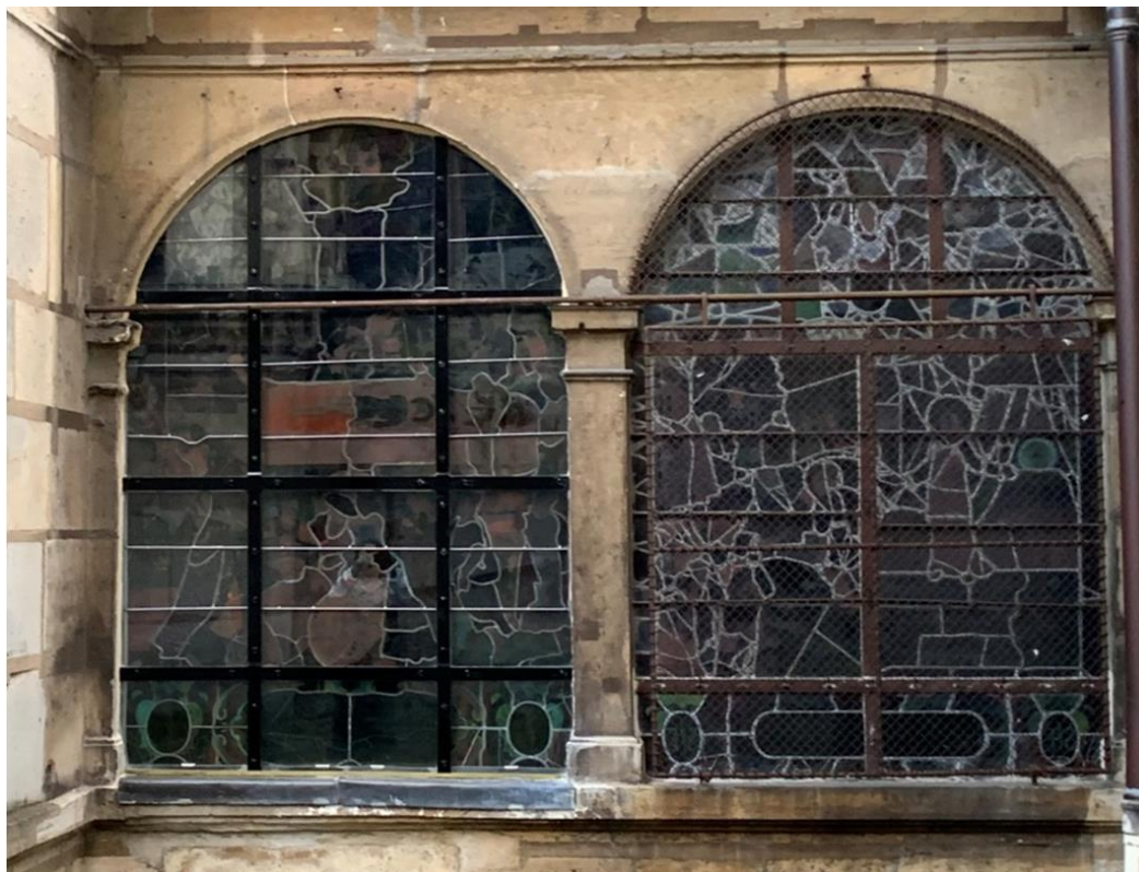
Fig. 2. Paris, église Saint-Étienne-du-Mont, vitraux du charnier, à gauche avec verrière de protection en verre incolore feuilleté, à droite avec grillage et sans verrière de protection. © Manufacture Vincent-Petit, 2019.
